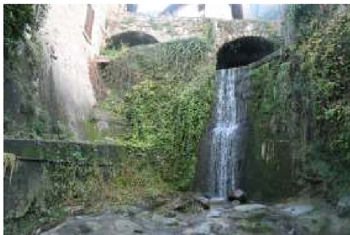
Foto 24: Sezione di chiusura porzione apicale (sezione D-D 1 ) vista da valle con ben evidente il salto dell'alveo nella parte pre-tombinatura.
