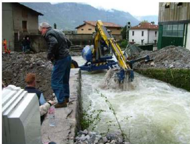
Foto 1: Intasamento e chiusura del tombotto di attraversamento stradale e ferroviario verso lago.
