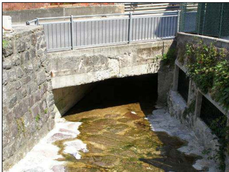
Foto 26: Sezione di chiusura porzione mediana (sezione H-H 1 ) vista da monte con in evidenza la griglia d'accesso al canale scolmatore.
