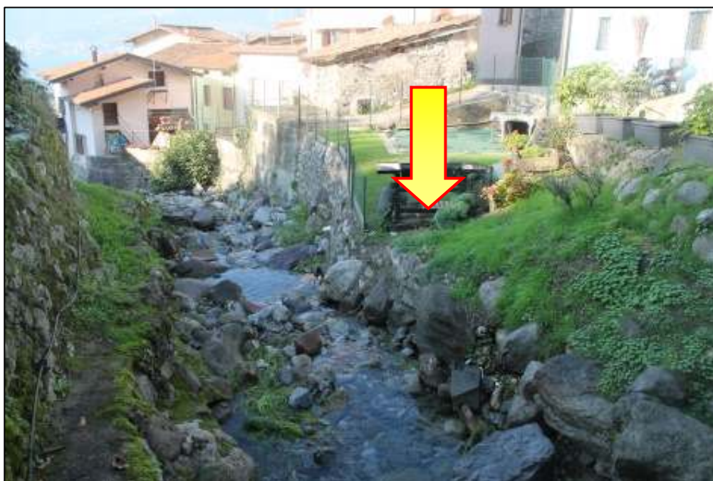
Foto 22: La freccia indica la potenziale via d'uscita di una colata detritica (spazio verde sulla destra).
