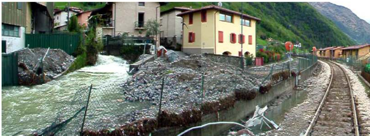
Foto 3: esondazione del torrente Tufere e deposito materiale sulla sede stradale.
