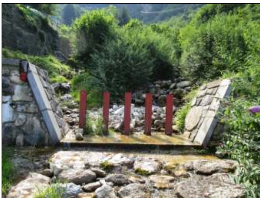
Foto 21: Briglia selettiva realizzata all'apice della conoide del torrente Tufere.
